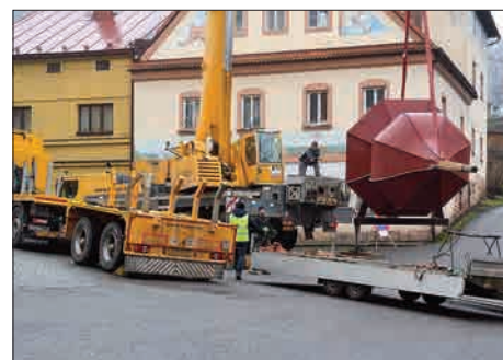
Instalace báně, firma Hanyš
