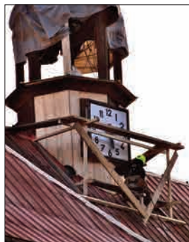
Nová konstrukce nesoucí věž
