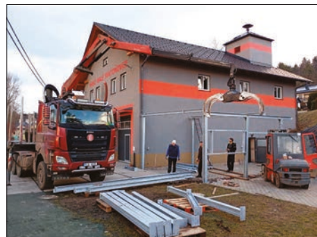
Přístavba nové garáže
