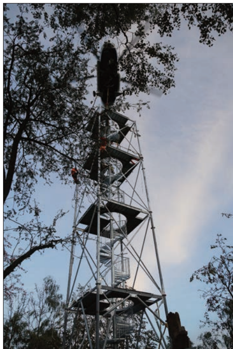
Usazování rozhledny po jednotlivých částech
