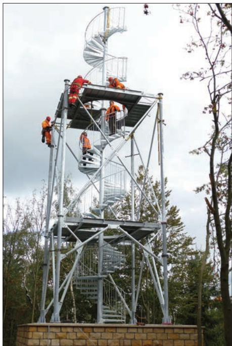
Usazování rozhledny po jednotlivých částech
