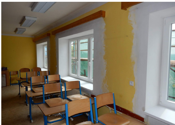
Rekonstrukce ZŠ (autor: Ing. Jan Tomek)
