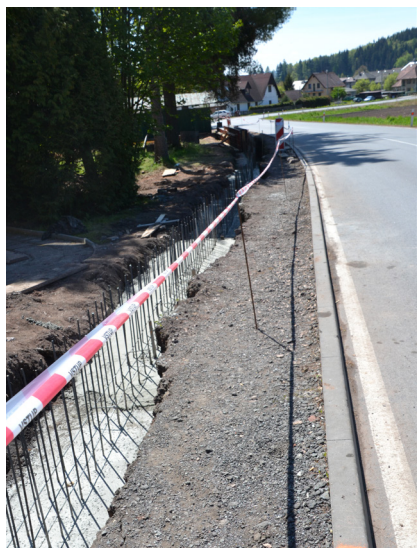
Přípravné práce na chodníku
