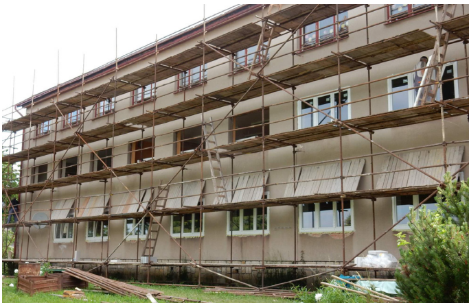
Průběh prací na ZŠ II. stupeň, autor: J. Tomek
