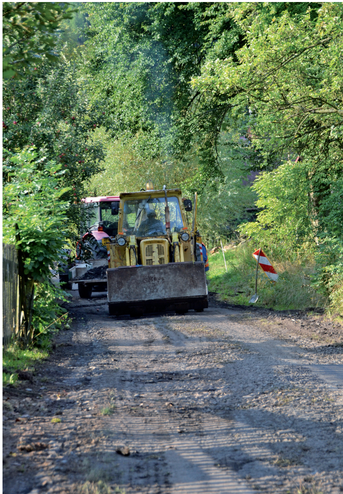
Foto z průběhu prací na opravách silnice ve Strážkovicích
