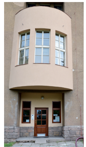
Opravený vchod na budově zš I. stupeň
