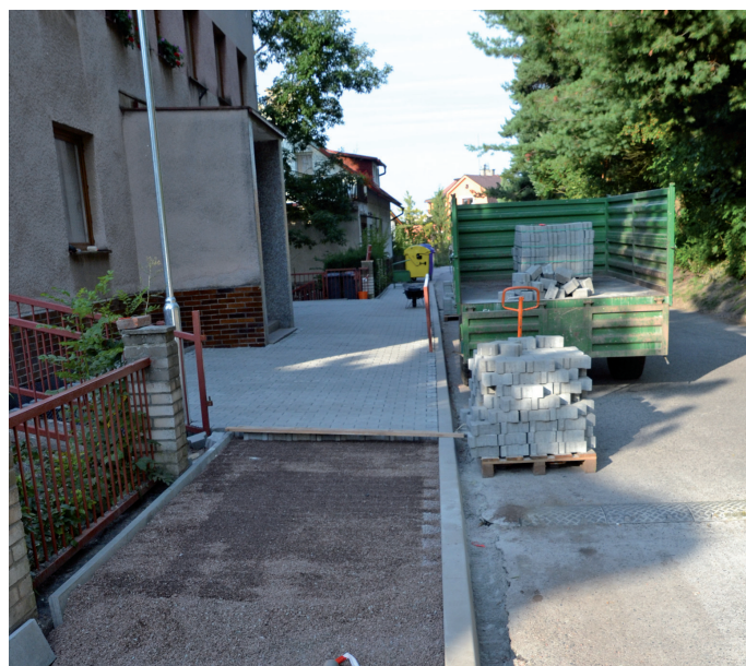
Z průběhu práce na novém chodníku před MŠ
