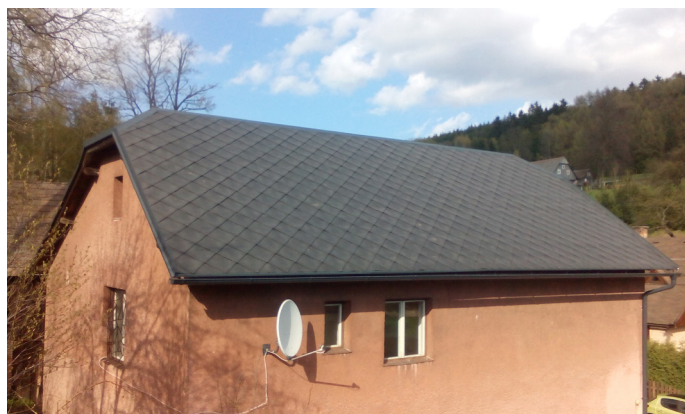
Nová střešní krytina na hasičárně ve Strážkovicích
