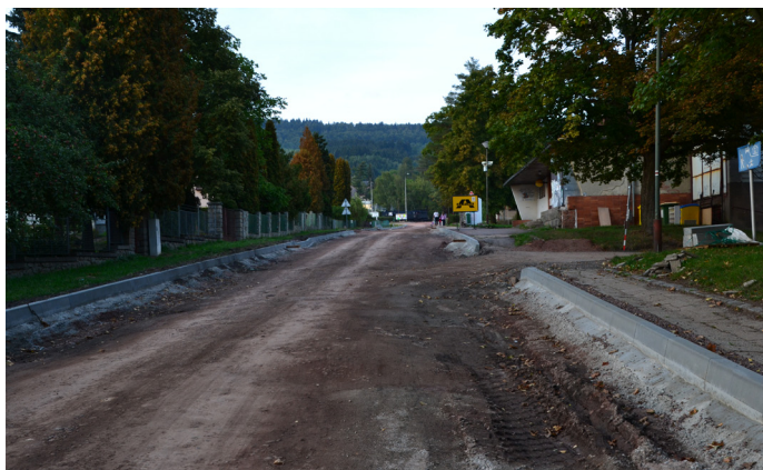
pozastavené práce na komunikaci
