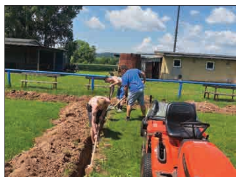
Příprava na zavlažovací systém
