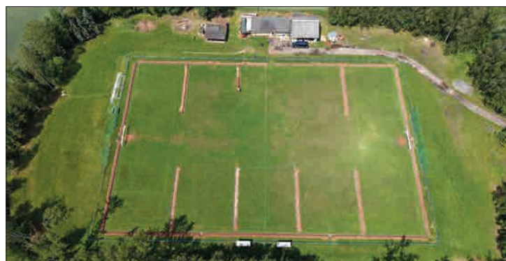
Pohled na hřiště při přípravách na zavlažovací systém
