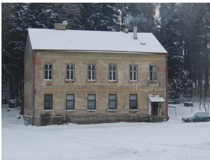
Obrázek 17: Objekt k bydlení ve vlastnictví obce Malé Svatoňovice v místní části Odolov
